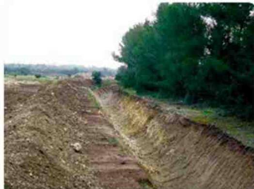
■ Fossé de dérivation des eaux en amont des sites
