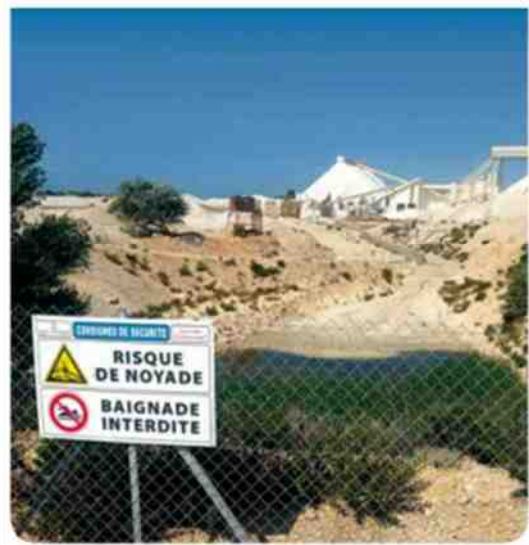
■ Bassin de décantation
