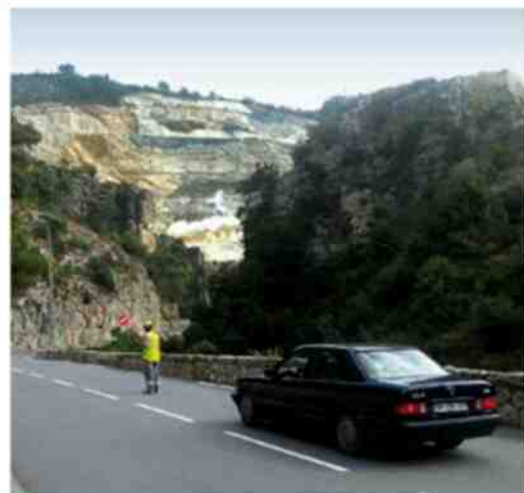
■ Gestion des risques de projections lors des tirs de mines
